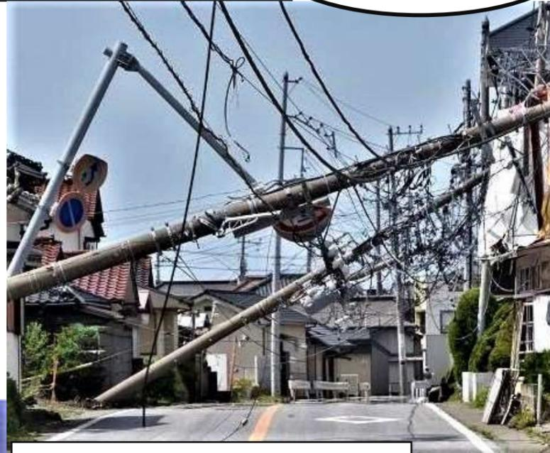
電柱の倒壊多発が長期間の停電の要因に
